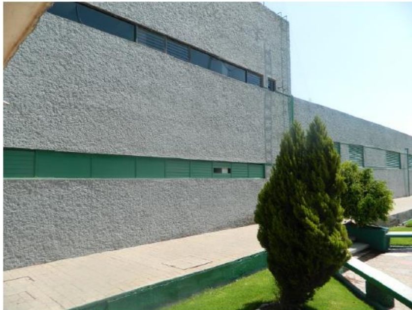
Área de talleres de mantenimiento
