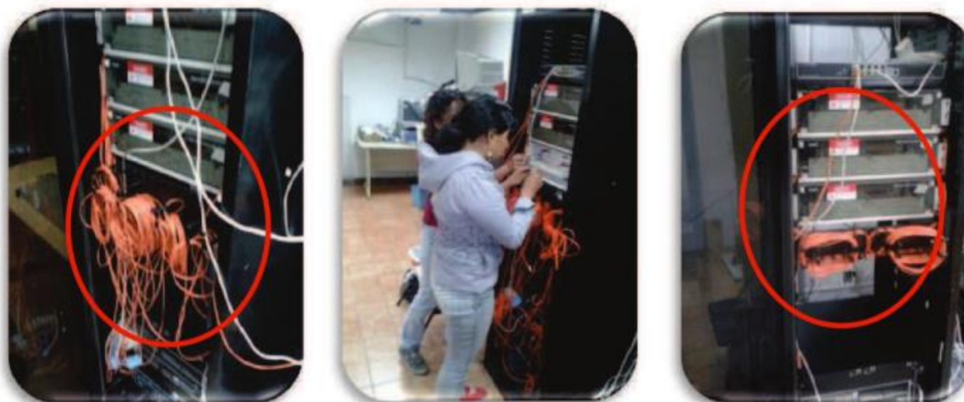
Reestructuración de cableado SITE de comunicaciones UTN (antes -durante-después).
